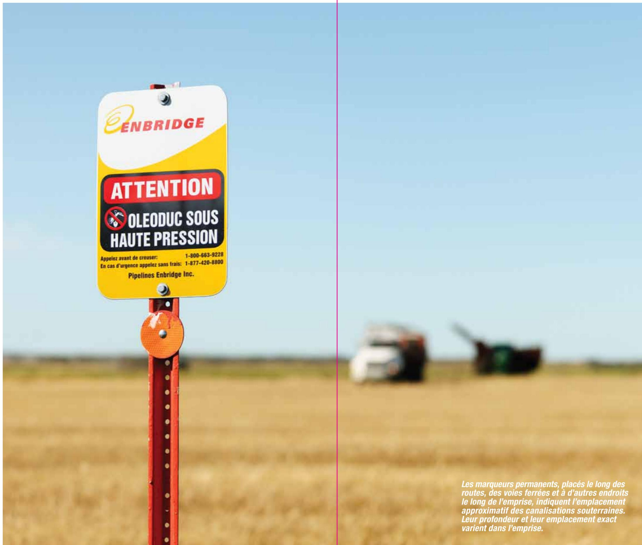
*Les marqueurs permanents, placés le long des routes, des voies ferrées et à d'autres endroits le long de l'emprise, indiquent l'emplacement approximatif des canalisations souterraines. Leur profondeur et leur emplacement exact varient dans l'emprise.*
