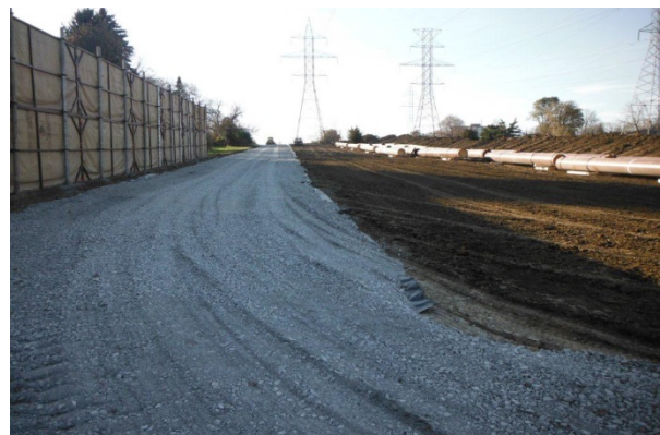
Figure 3 – Préparation en vue du bardage
