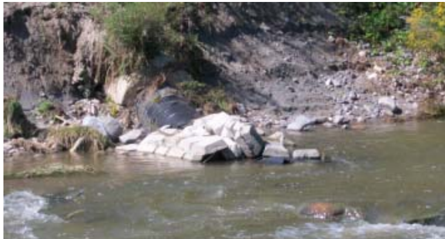
Figure 7 – Muret de béton temporaire à la rivière Rouge
