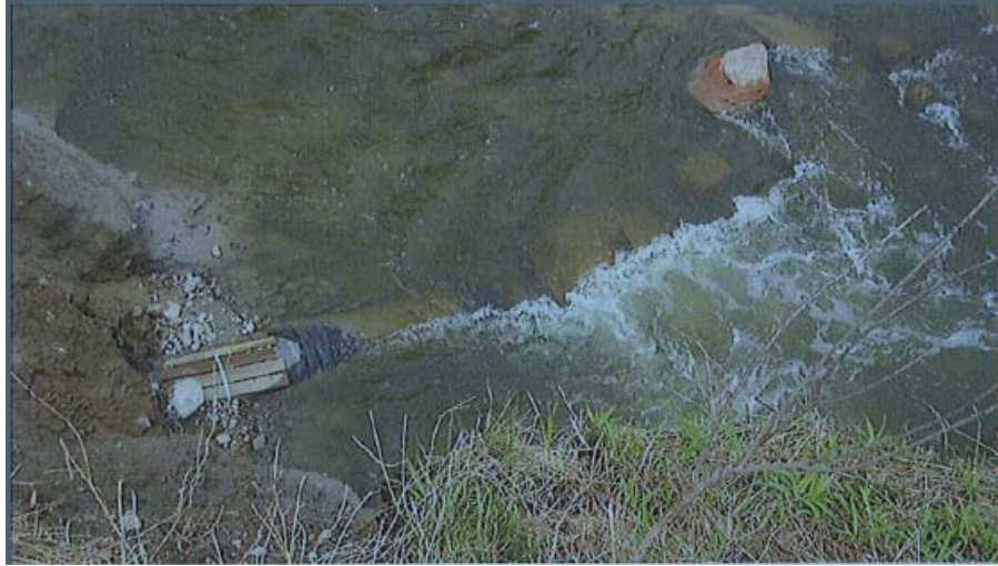
Figure 6 – Pipeline mis à nu à la rivière Rouge
