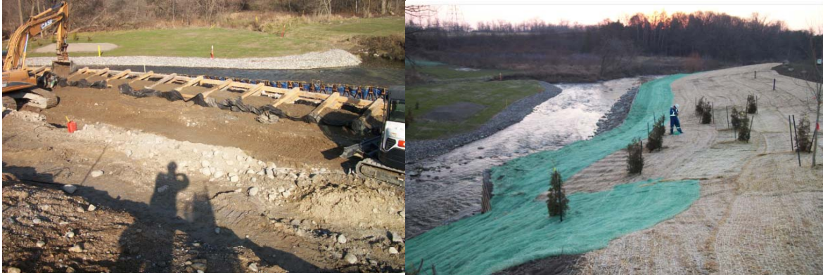
Figure 8 – Construction à la rivière Rouge en 2012 Figure 9 – Construction à la rivière Rouge en 2012
