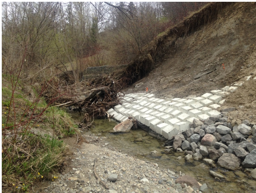
Figure 11 – Muret de béton temporaire au ruisseau Newtonbrook
