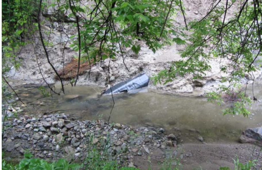
Figure 10 – Mise à nu du pipeline au ruisseau Newtonbrook
